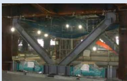
超高層タワーには高度な制振装置「オイルダンパー」を356台設置
